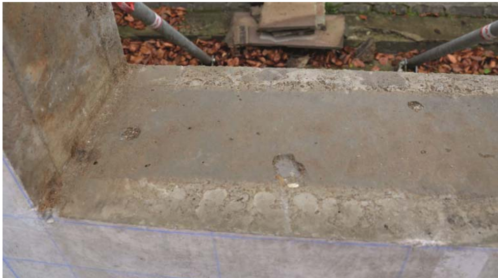
Abbildung 23: Fensterbereich nach der Betonage
