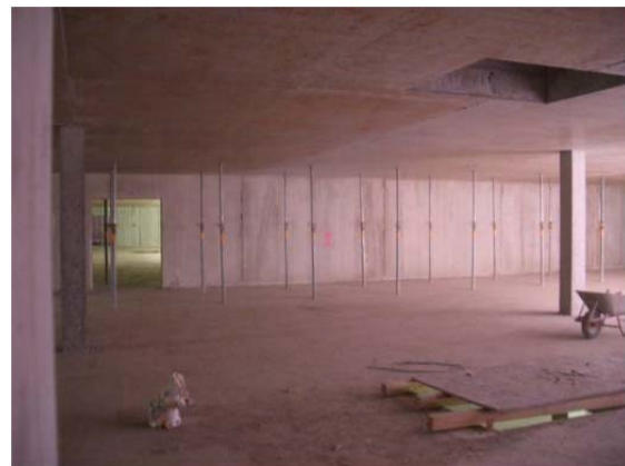
Abbildung 7: Innenansicht des Magazinegebäudes
