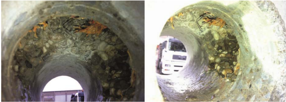
Abbildung 30: Überprüfung der Lage des Kiesnestes
