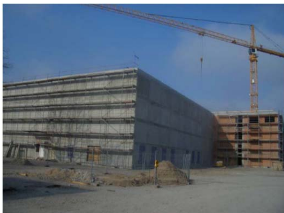
Abbildung 6: Außenansicht des Magazinegebäudes
