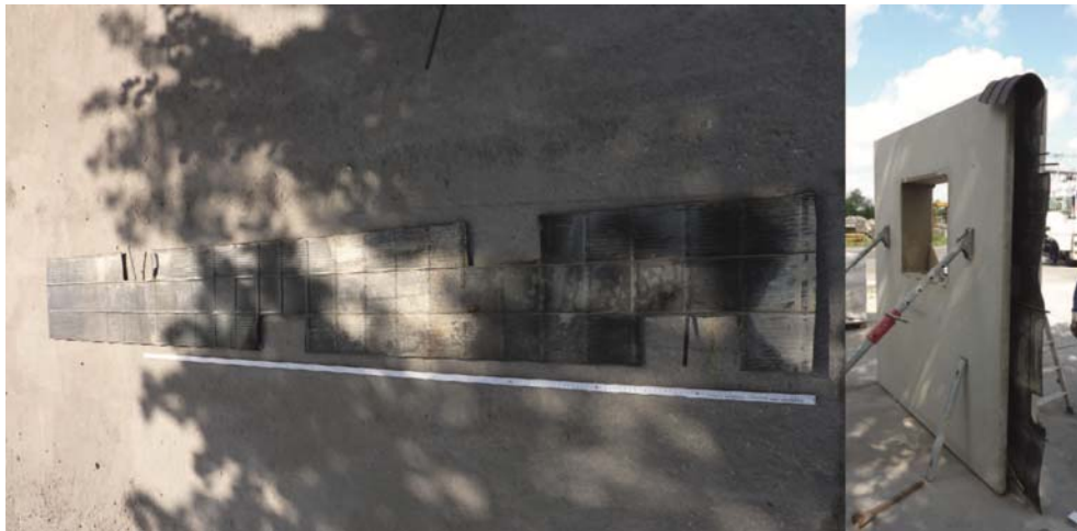
Abbildung 21: Fugenband (b = 32 cm) im Übergang Wand B zu Wand C
