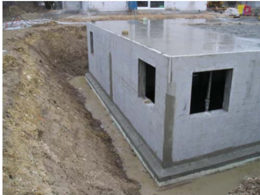
Abbildung 1: Rohbau des WU-Bauwerkes ausgeführt als Elementwandkonstruktion [18]
